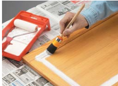
Schilder bij voorwerpen met profielen eerst de profielen en een randje daarnaast en daarna pas de grotere vlakken. Een ronde kwast is hier handiger dan een platte.
