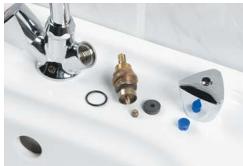
Van links naar rechts: kraan, O-ring, bovendeel, leertje en greep.
