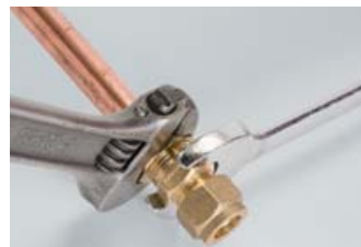
De knelkoppeling wordt hier met behulp van een steeksleutel en verstelbare moersleutel aangetrokken.
