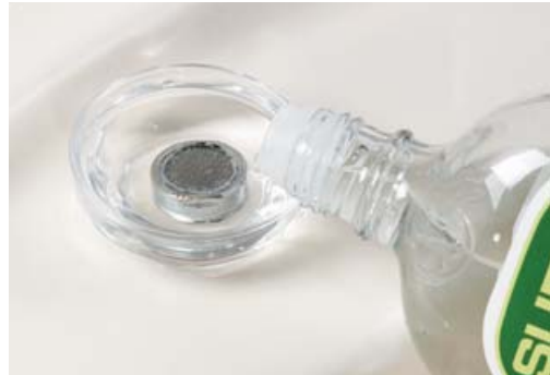
Azijn of een ander geschikt zuur lost de kalk op. Vergeet de sluitring niet bij het weer aanbrengen van het mondstuk.
