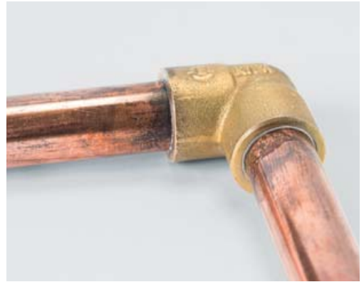
Als het soldeer zichtbaar wordt, is het uitgevloeid; laat de verbinding onbeweeglijk afkoelen.
