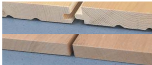
Vloerdelen met mes en groef (boven) en stompe vloerplanken (onder).
