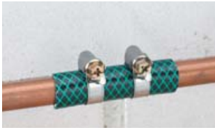
Een stuk open-gesneden tuinslang en twee slangklemmen om een lek tijdelijk te dichten.
